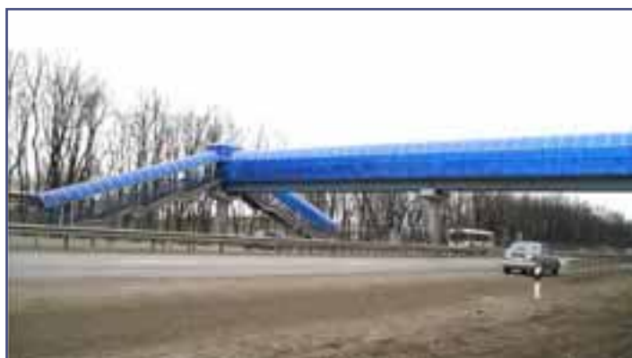
Пешеходный переход. Покрытие ЦИНОТАН +ПОЛИТОН-УР
