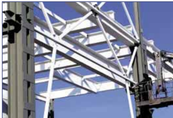
ТЭЦ. Нанесение покрытия ЦИНОЛ на металлоконструкции.
