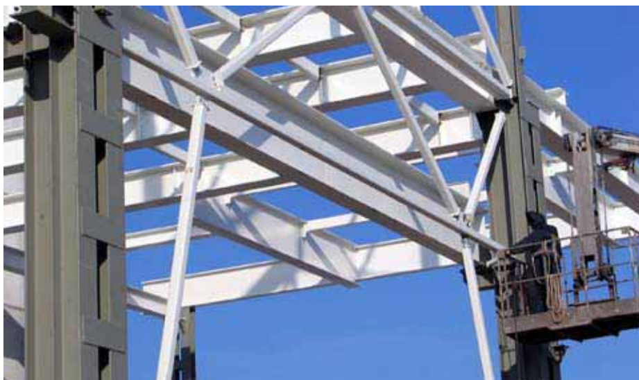
Нанесение покрытия ВМП на металлоконструкции ТЭЦ, Латвия, г. Рига
