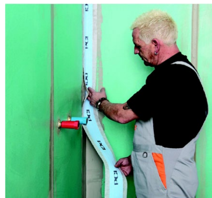
Гидроизоляционная лента PCI Pецitape встраивается во влажный слой используемого гидроизоляционного материала
