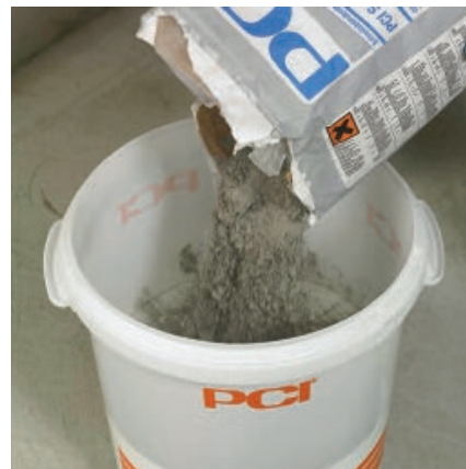
Добавить порошок PCI Seccoral 2K Rapid.
