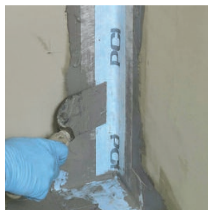
Наклеить гидроизоляционную ленту PCI Pесitare в углах.
