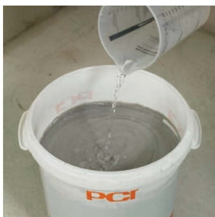
Добавить воды для нанесения валиком (1 б).
