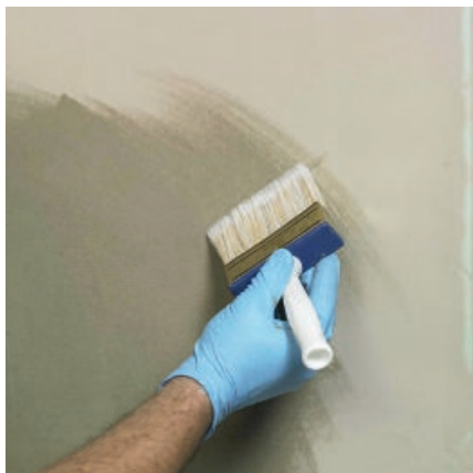
Увлажнить обрабатываемую поверхность.
